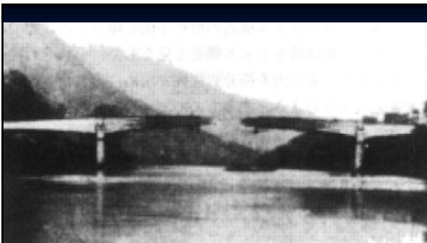
R C 橋の張出し施工 (L=68.5m) (ブラジル, 1930年)
