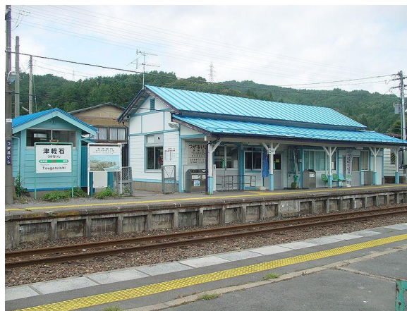
図 2-36 被災前の JR 津軽石駅舎
