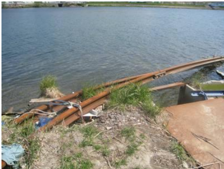
図 2-21 水没したレール(左岸)
