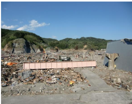
図 2-32 流された橋桁
