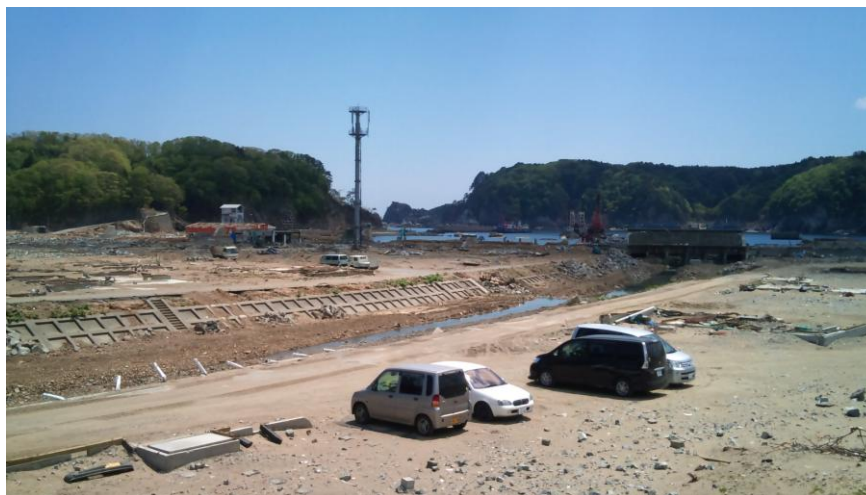
図 2-6 防潮堤から見た B 地区 (中心に見える川は長内川)
