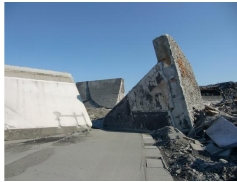
図 2-31 道路に倒れ込む堤防
