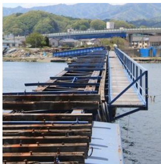
図 2-23 線路が剥がれ落ちた橋梁上部
