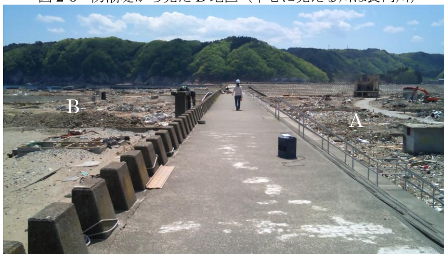
図 2-7 幅 3 m の防潮堤
