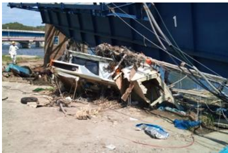
図 2-26 漁船が衝突した桁①
