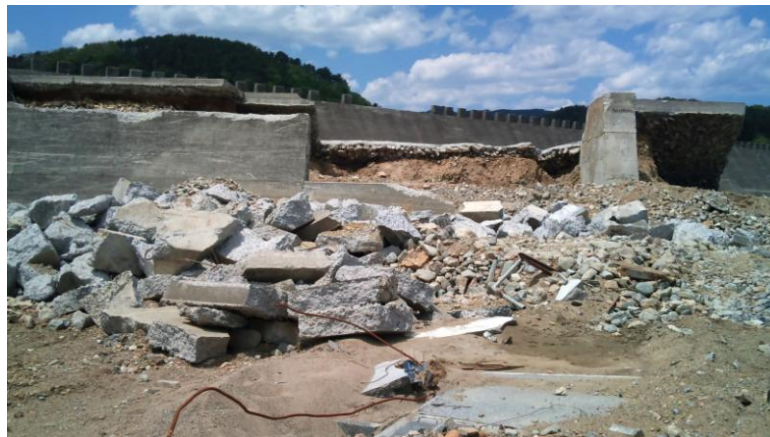
図 2-9 B 地区と海を隔てる防潮堤
