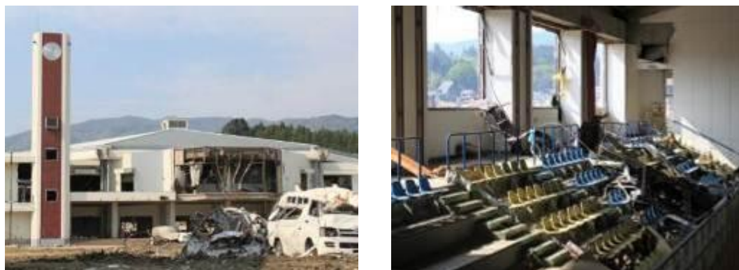
図 3-7 海側から撮った体育館(左) 体育館 2 階部(右)
