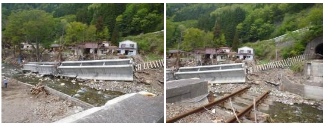
図 3-4 流出した橋桁
