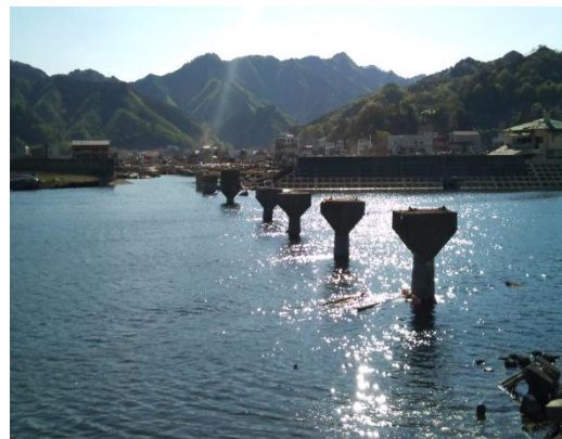
図 2-33 大槌川に残された橋脚
