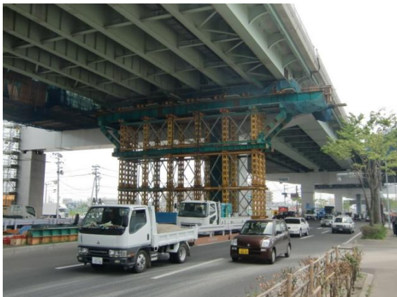
図 1-3 復旧工事の進む高架橋
