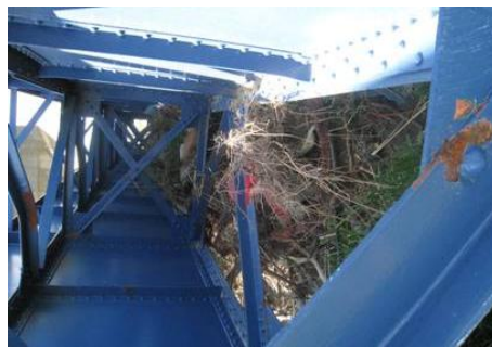
図 2-29 網が絡む桁②
