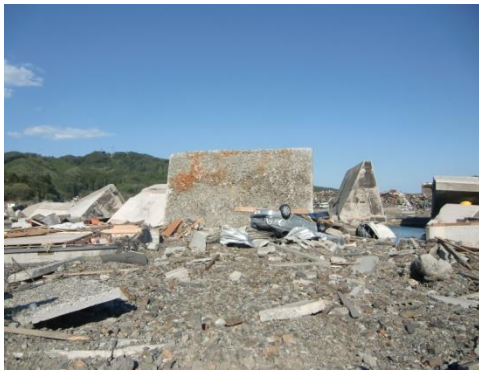
図 2-30 津波で破壊された堤防
