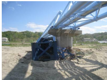
図 2-19 流失した桁②
