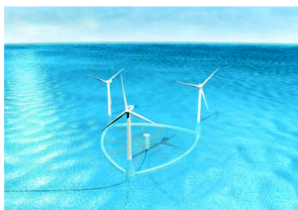
セミサブ式の浮体。三角形の本体には、各頂点に風車が設置される
