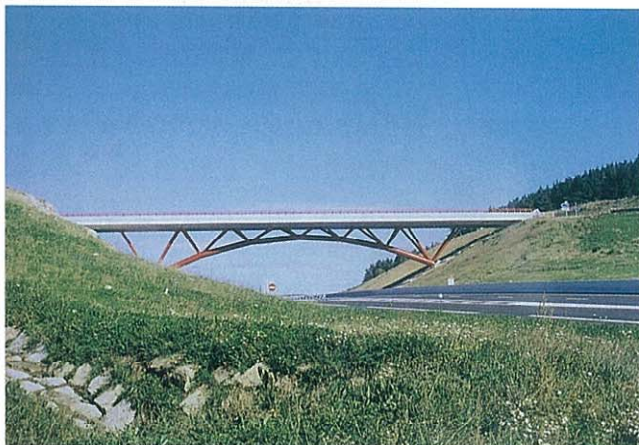
写真-22 高速 A75のアントゥルナス・インターチェンジ橋
