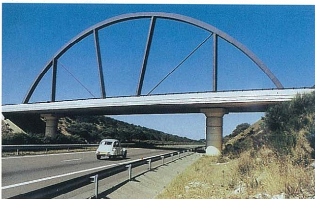
写真-12 クレルモン・フェランのA71高速自動車道に架かる跨道橋（標準的なスラブ橋の上に単なる装飾としてのアーチが載っているもので、構造的には虚構である）（撮影：Scetauroute）
