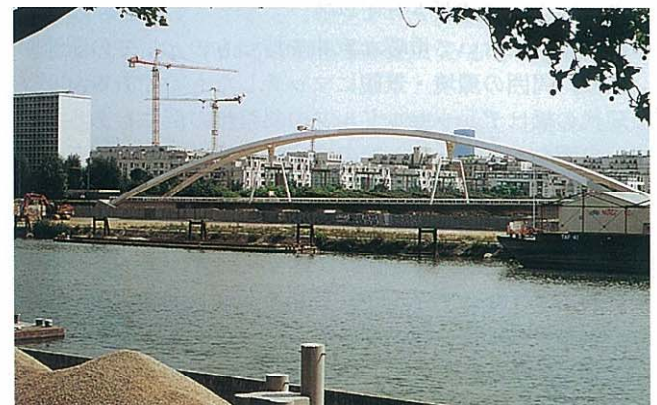
写真-8 シトロエン工場の橋（橋床は橋脚によって支持されていて、アーチはまったくの飾りでしかなく、構造が虚構である橋の例）
