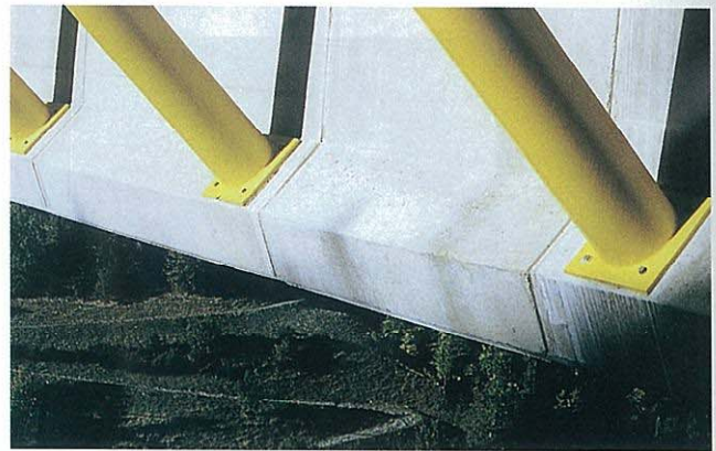
写真-18 高速 A75のピユ高架橋 (ストラット部)
