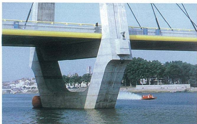
写真-29 同上, 主塔における力の流れが明解 (撮影: G.Forquet)
