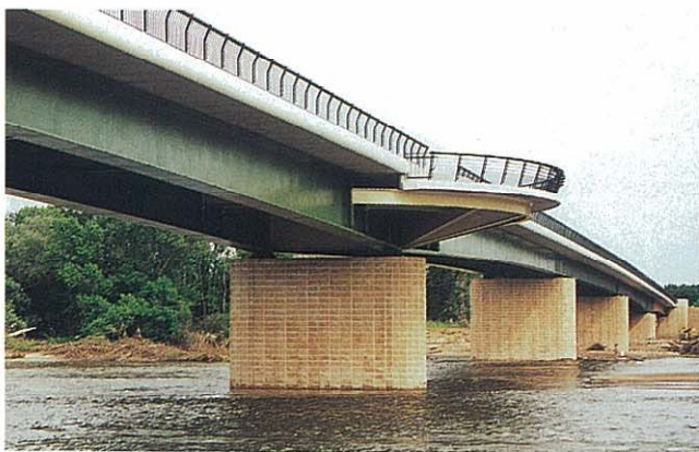
写真-11 アリエ川に架かるゲタン橋（桁高の変化に論理的裏付けがない。また、歩行者用の休憩バルコニーがこの橋の線形を崩している）
