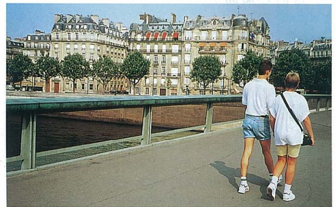
写真-7 アルマ橋の透明でモダンな高欄
