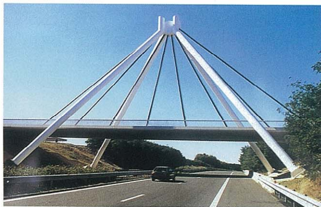
写真-13 フランス中央部の高速A75に架かる跨道橋（構造的にはあまり論理的ではないが、この形状の示すとおりに機能している実直な橋である）（撮影：Scetauroute）
