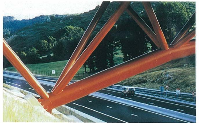
写真-23 アントゥルナス・インターチェンジ橋のパイプトラス桁 (撮影: J.Berthelémy)
