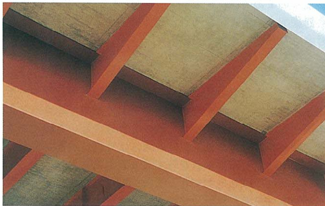
写真-16 プランシェット高架橋の桁構造の細部
