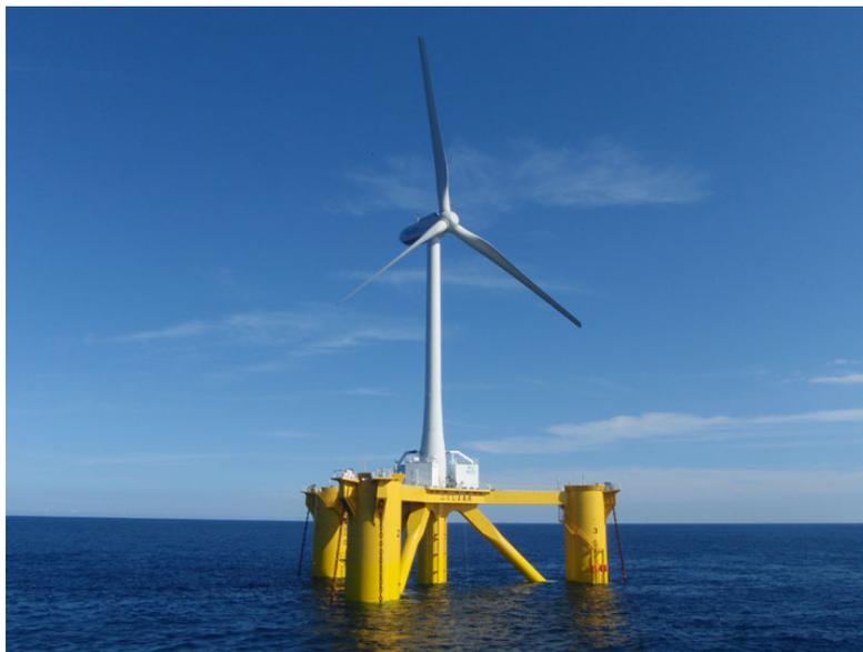
図 1 浮体式洋上風力発電設備の「ふくしま未来」(出典: 福島洋上風力コンソーシアム)
